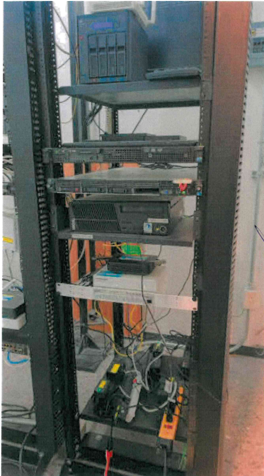
Site con nuevos no breaks, servidor de telefonía, servidor de archivos, servidor web, NAS de almacenamiento y servicio de Internet de Telmex.
