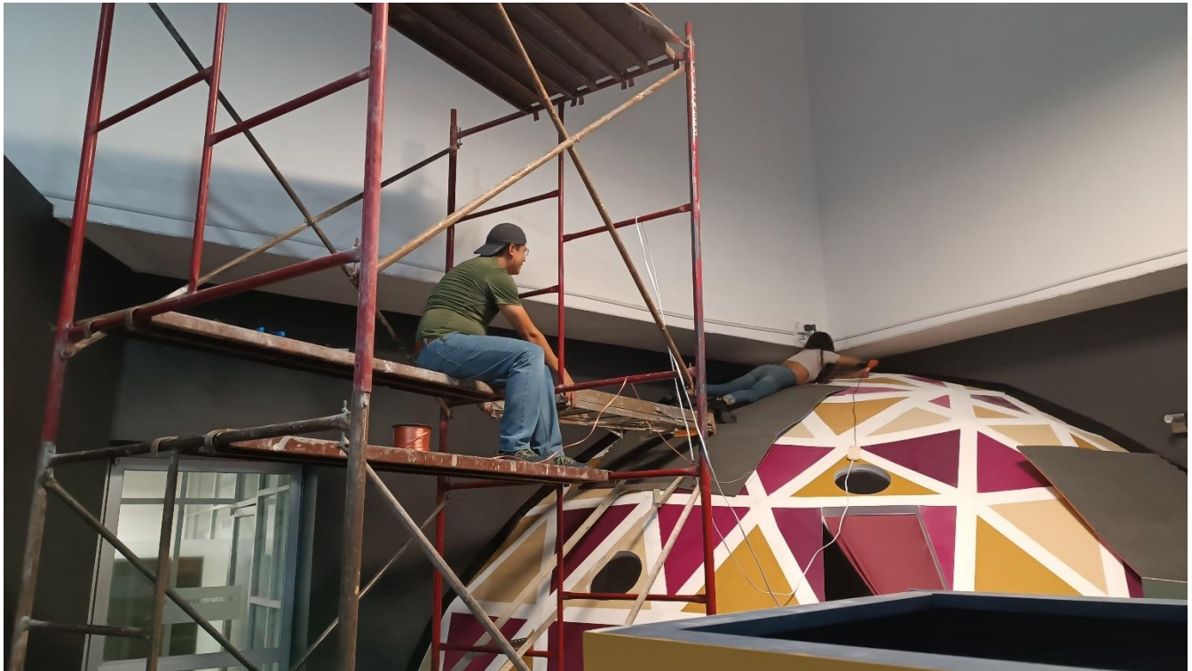
Instalación de luces led en el Centro de Cultura Digital de Hidalgo.
