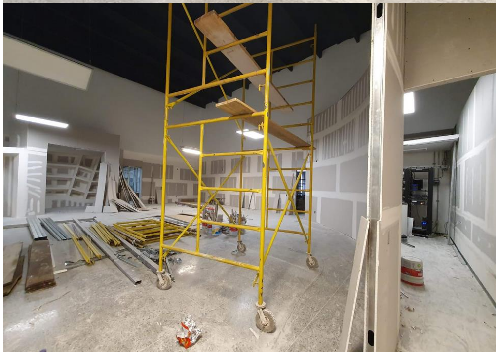
Remodelación de espacio para el Centro de Cultura Digital (2021)
