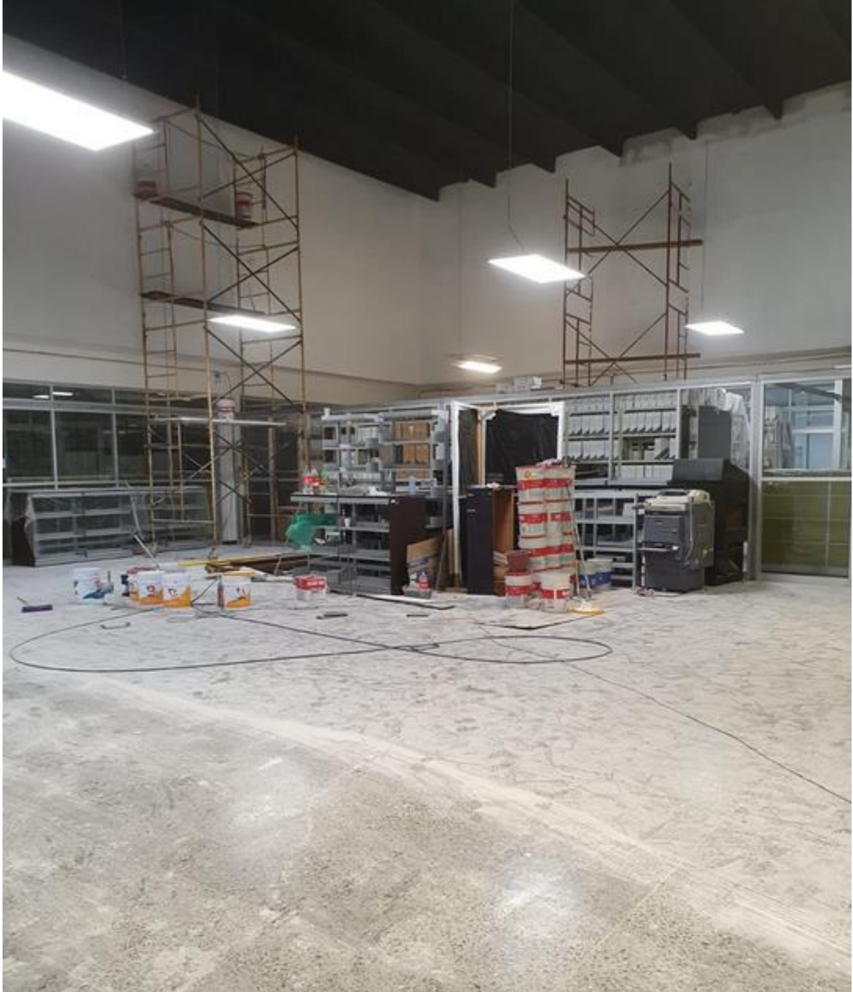
Inicio de remodelación de espacio
