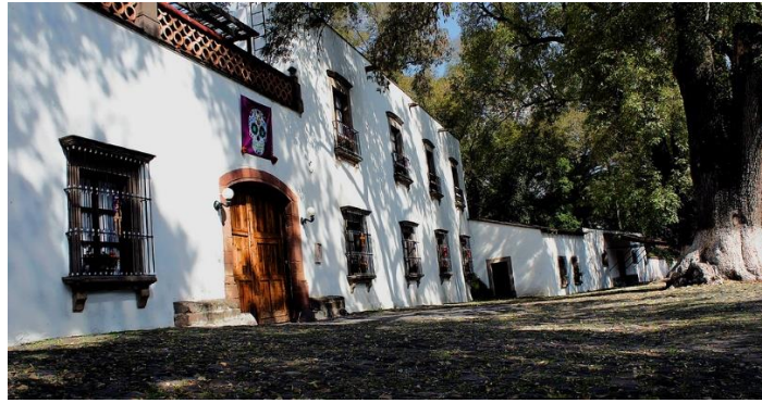
Figura 5. Hacienda de la Cañada.
